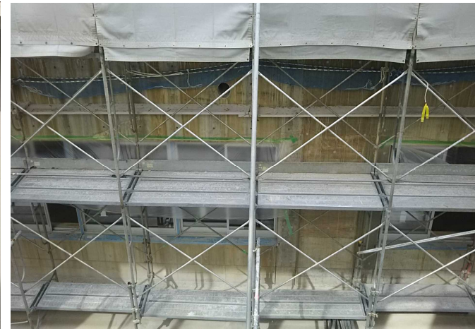
③教室・特別・管理棟建設地
