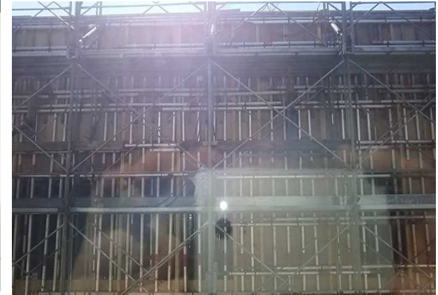
③教室・特別・管理棟建設地
