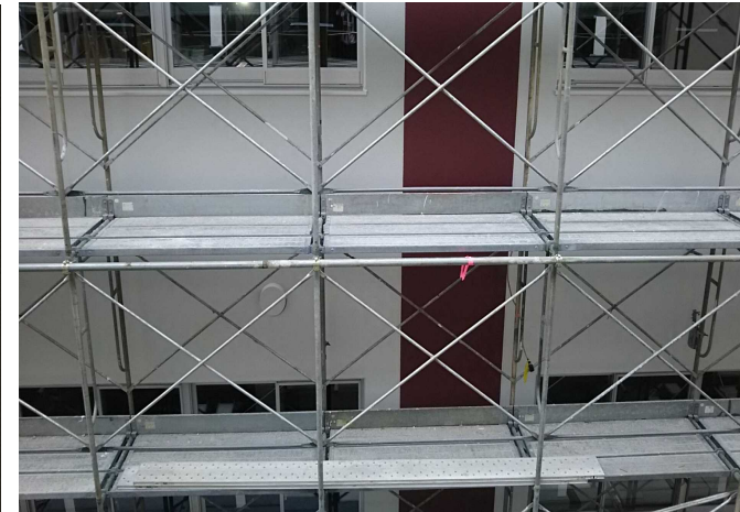
③教室・特別・管理棟建設地
