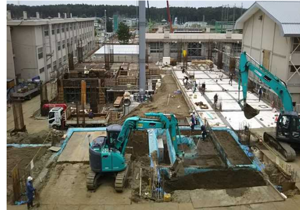
③教室・特別・管理棟建設地
