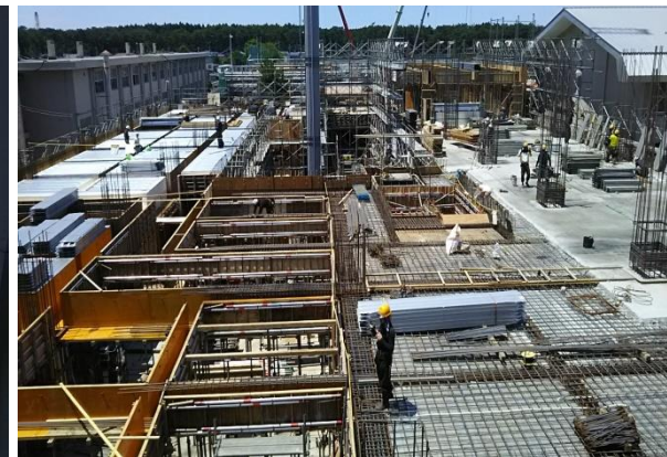
③教室・特別・管理棟建設地
