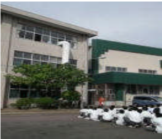
【救助袋による避難・管理棟】
